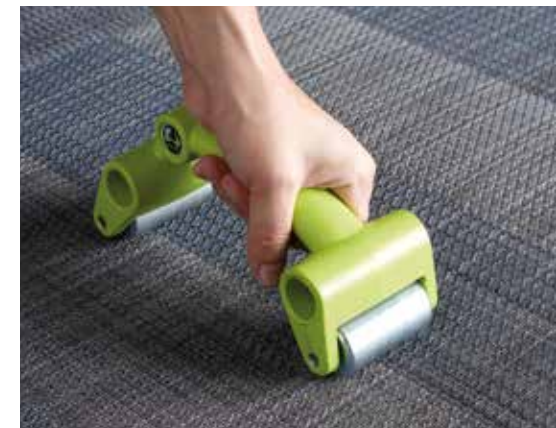
Wygładź miejsca łączów za pomocą wałka dociskowego.
