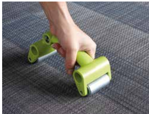
Wygładź miejsca łączów za pomocą wygładzającego wałka dociskowego.
