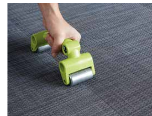
Wygładź miejsca łączów za pomocą wałka dociskowego.
