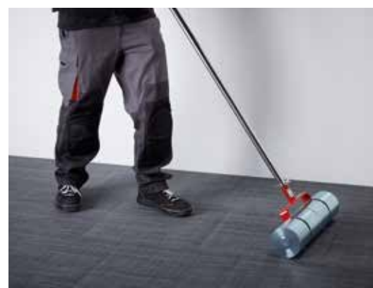
Wygładź płytki na całej powierzchni za pomocą wygładzającego wałka dociskowego.
