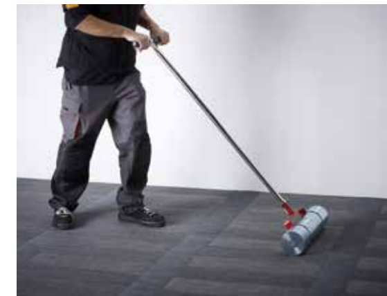
Wygładź panele na całej pokrytej powierzchni za pomocą wygładzającego wałka dociskowego.
