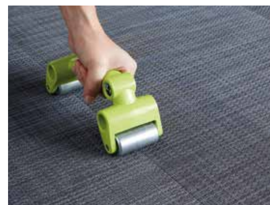
Wygładź miejsca łączów za pomocą wałka dociskowego.
